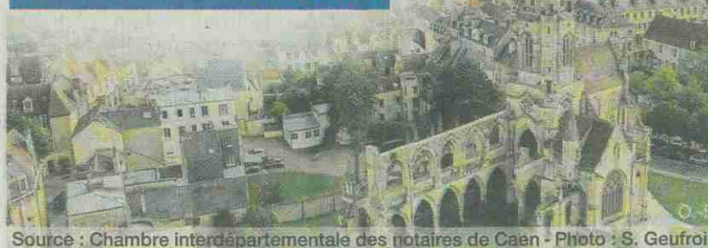
Source : Chambre interdépartementale des notaires de Caen - Photo : S. Geufroi.
